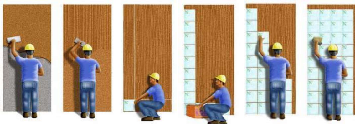
Imagem 001 – Sequencia para assentamento do revestimento cerâmico
