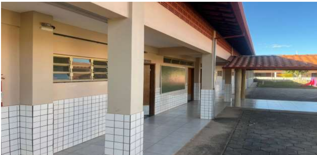
Foto 3: Escola que serão construídas duas salas de aula.
