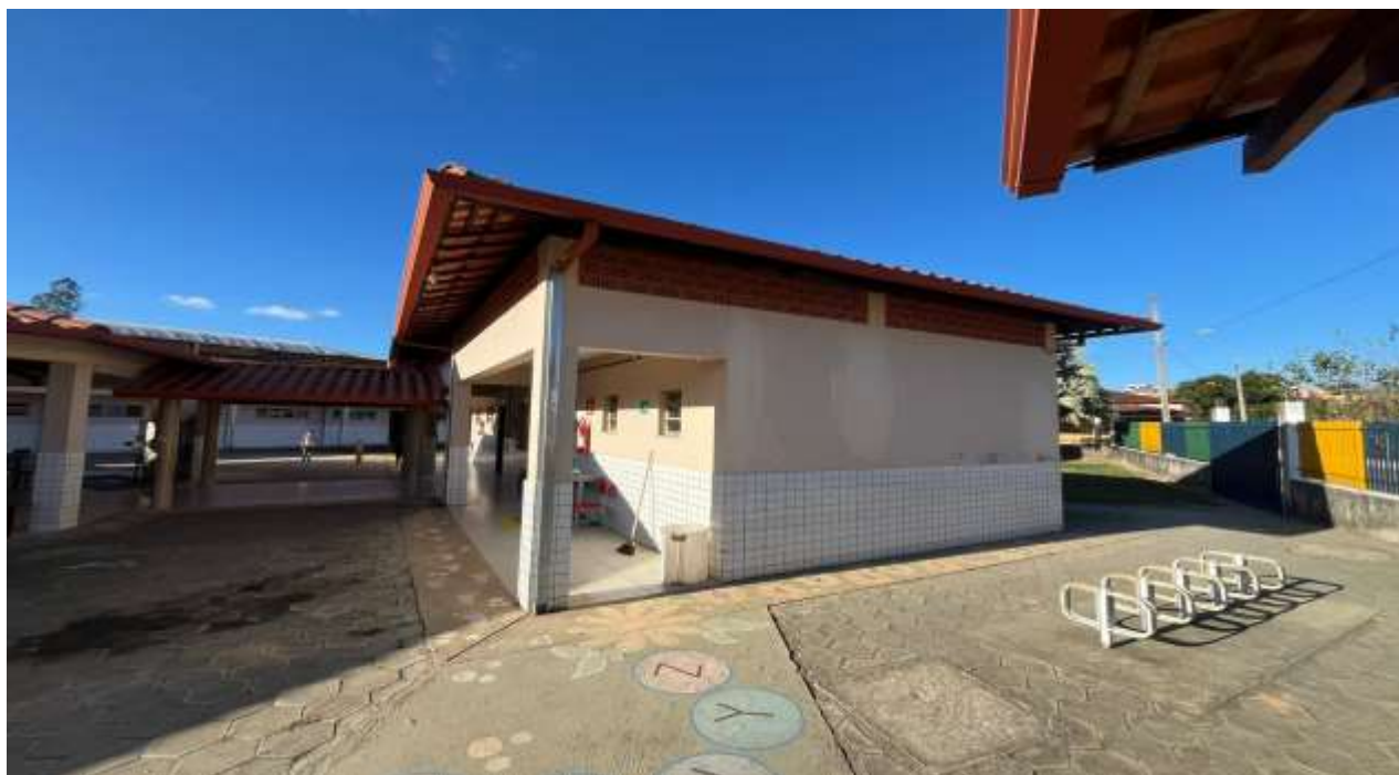
Foto 2: Escola que serão construídas duas salas de aula
