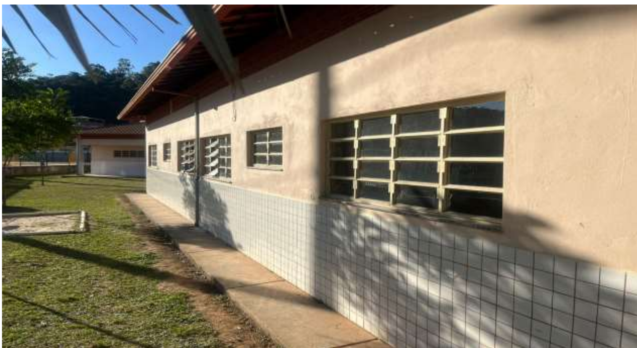
Foto 4: Escola que serão construídas duas salas de aula.
