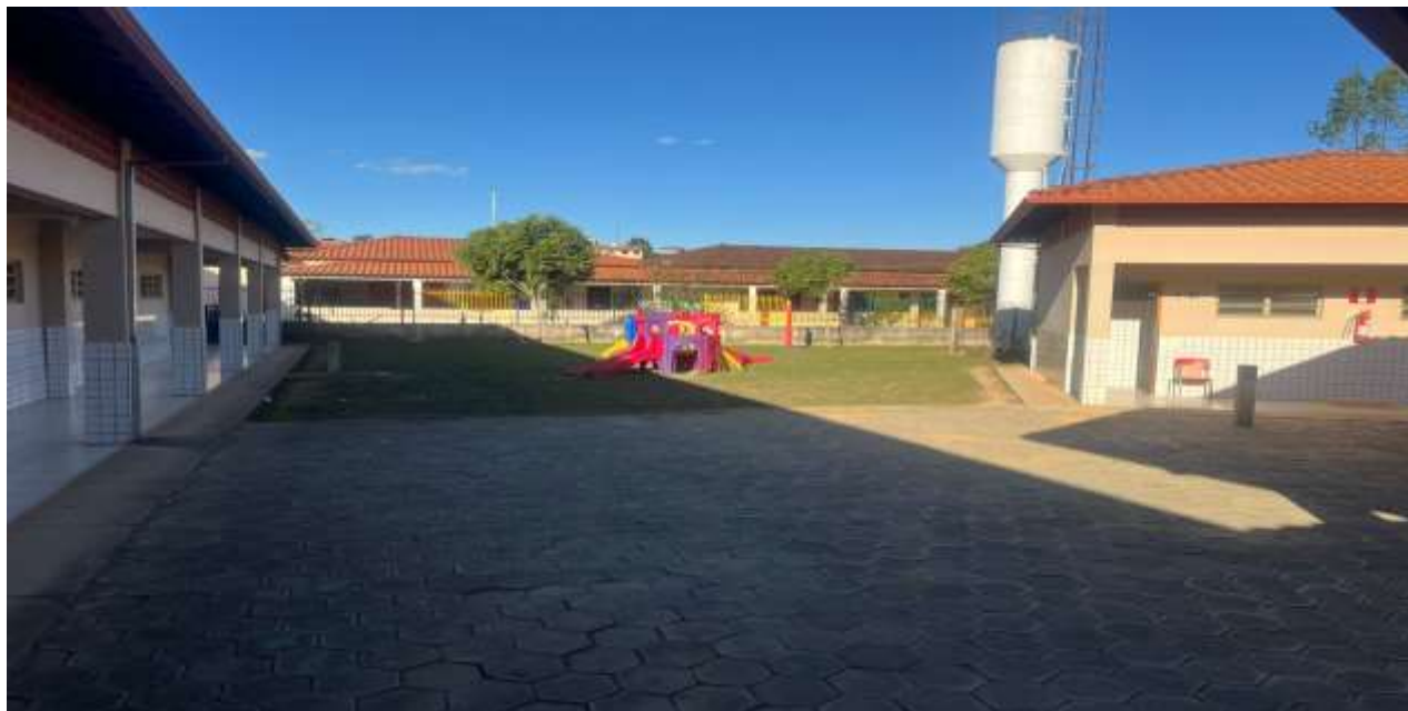
Foto 1 : Local onde serão construídas duas salas de aula.
