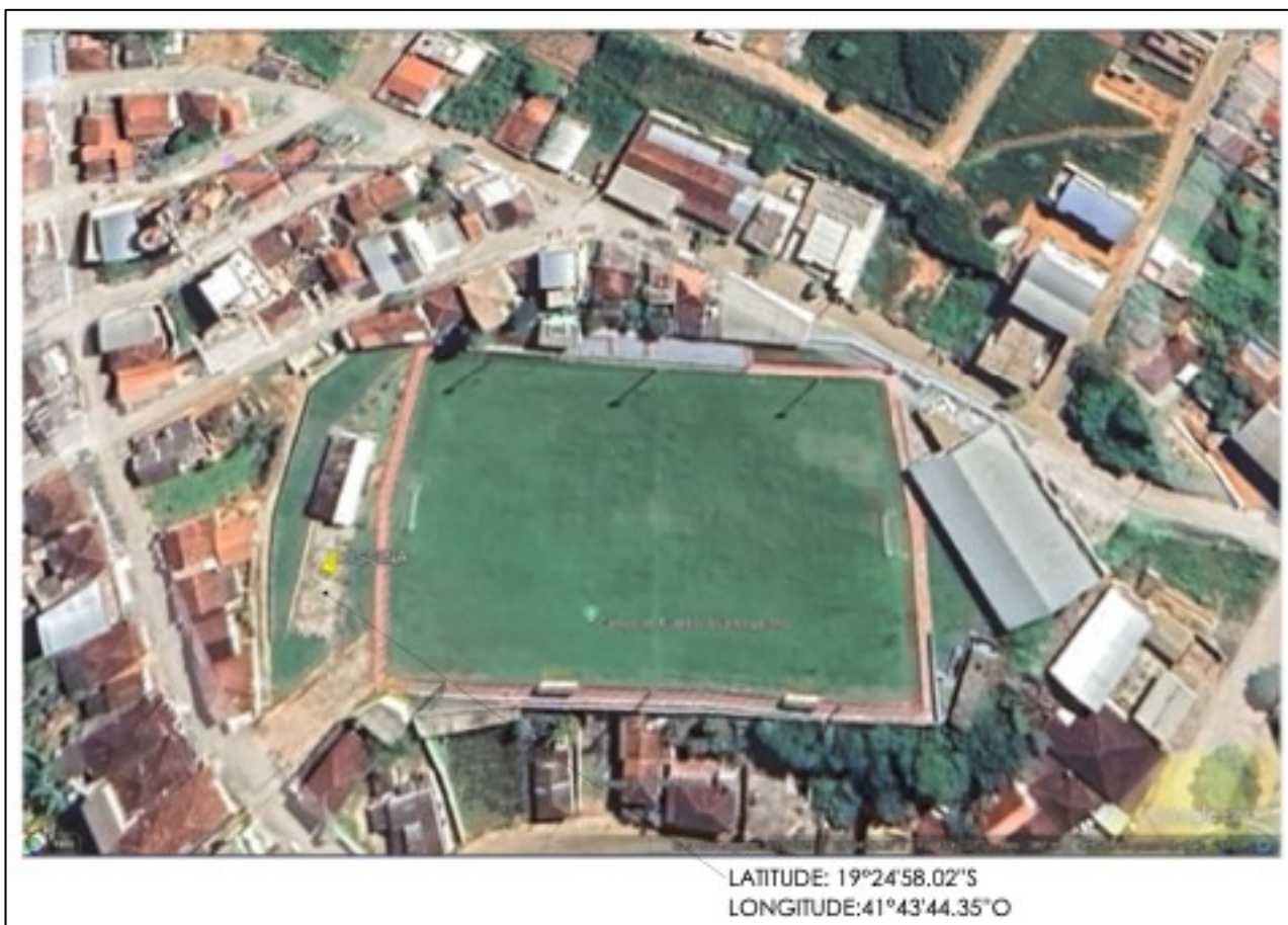
Imagem 01: Localização via satélite e local da intervenção
